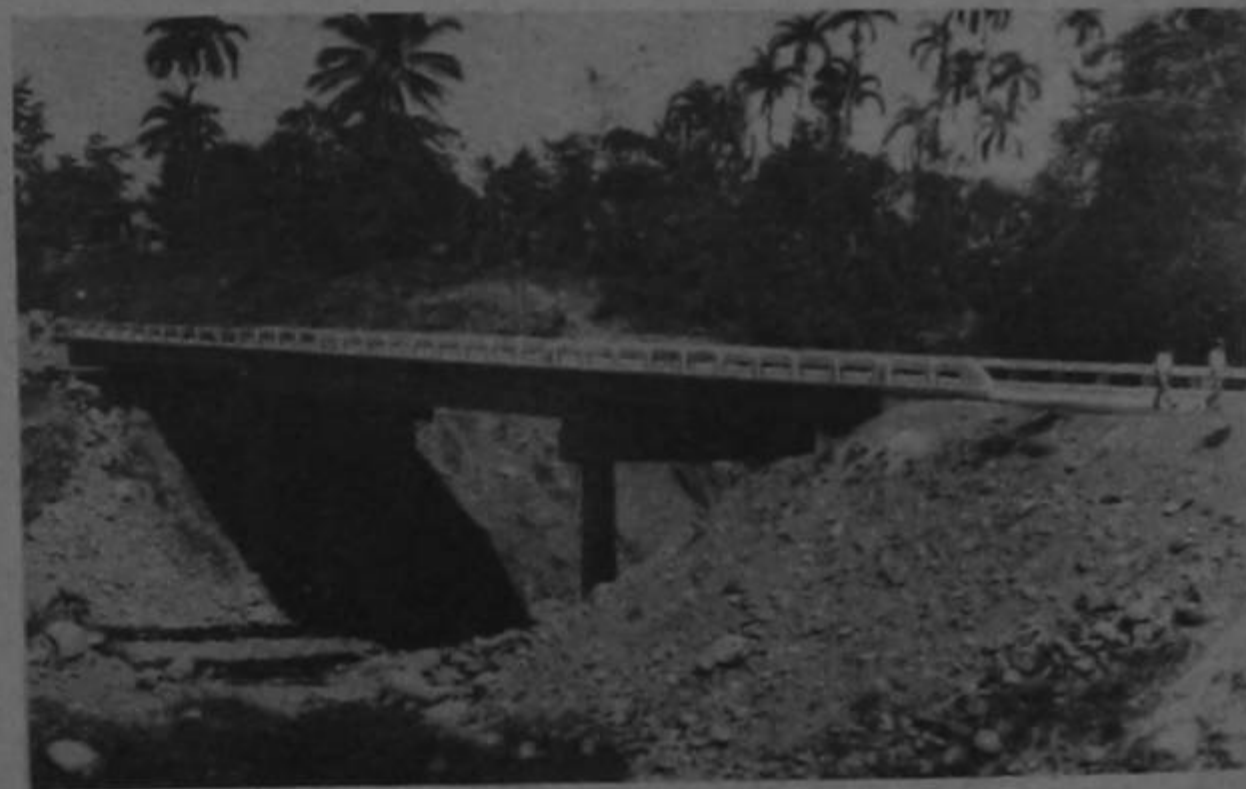
PUENTE SOBRE EL RIO SIQUIRRES. - En el proyecto ubicado entre Siquirres y Limón, sobresale la estructura del puente sobre el río Siquirres.
