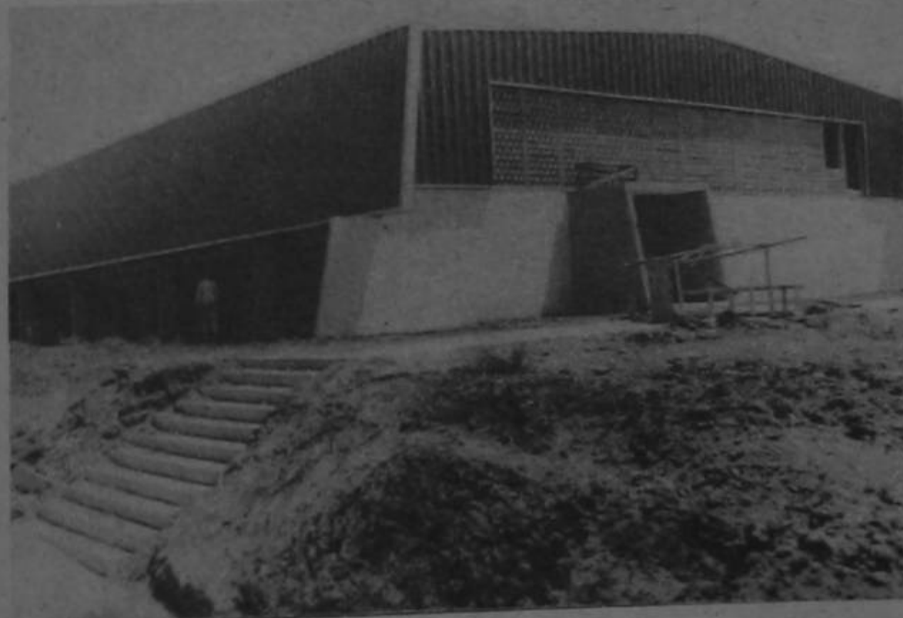
GIMNASIO DE CURRIDABAT. - Dentro de las grandes obras que se construyen, con el fin de aumentar el nivel educativo en nuestro país, el Ministerio de Obras Públicas y Transportes, ha concluido recientemente el gimnasio del Liceo de Curridabat.
