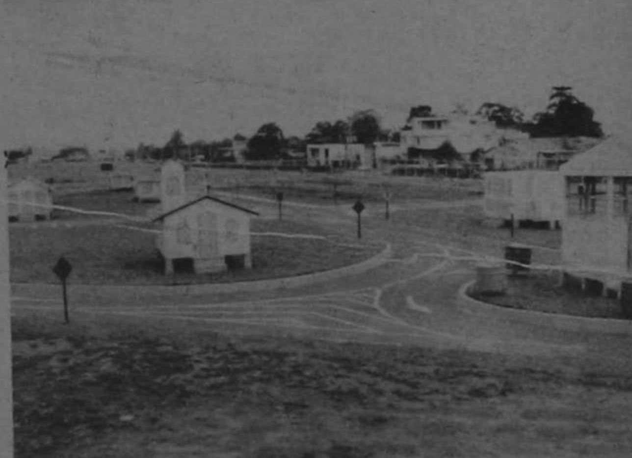
EDUCACION VIAL. - La Escuela Vial ubicada en la "Ciudad de Los Deportes", en la Sabana, resulta ser una obra de vital importancia, construida por el Ministerio de Obras Públicas y Transportes. La misma está orientada a educar a la niñez en lo que respecta a normas de tránsito, evitándose así, posibles accidentes. La Escuela Vial está provista de las señales de tránsito existentes y se espera impartir unas 85 mil lecciones al año, con lo que se logrará un buen incremento en lo que respecta a la educación vial en nuestro país.
