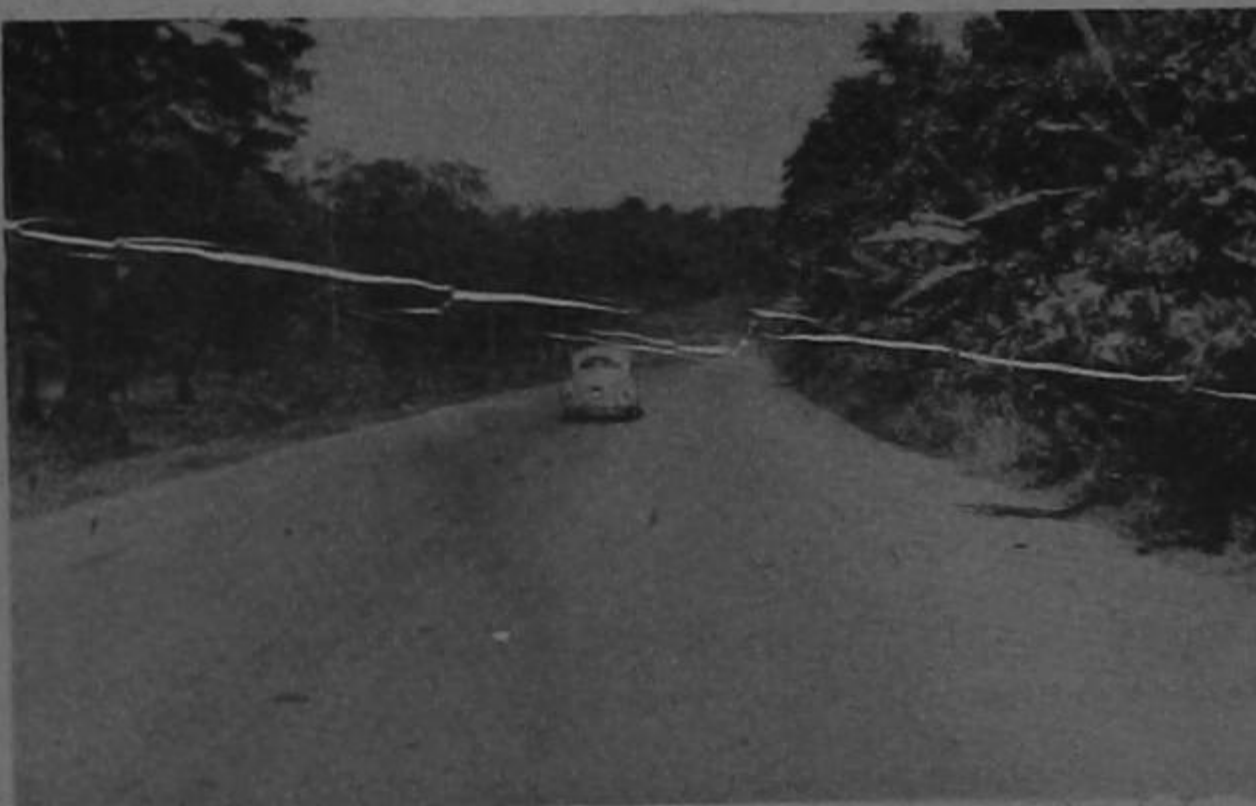
El Ministerio de Obras Públicas y Transportes ha concluido recientemente la carretera entre Siquirres y Limón de 59 kilómetros de longitud, con un costo superior a los 134 millones de colones.
