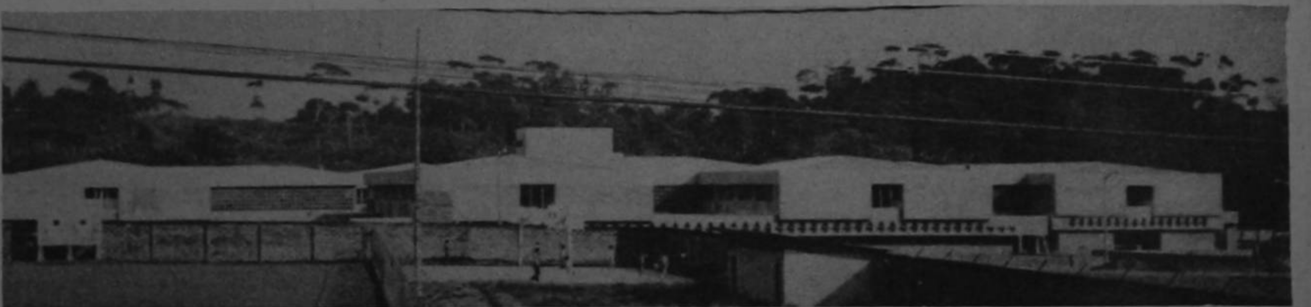
Este es el moderno hospital que construye la Caja en San Isidro de El General a un costo que supera los 50 millones de colones. Probablemente entre en servicio antes de fines de año.
